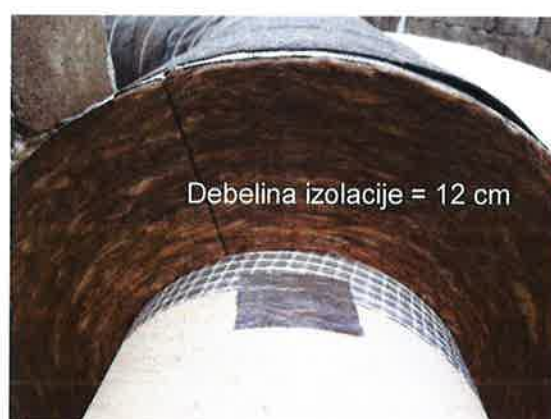
Slika 9 LEVO: Stanje izolacije pred sanacijo; DESNO: Nov izolacijski sloj cevovoda
