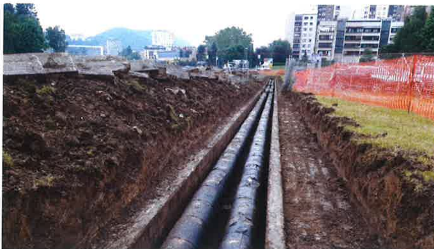
Slika 4: Odpiranje kinete vročevoda (pogled v smeri J 5035)
