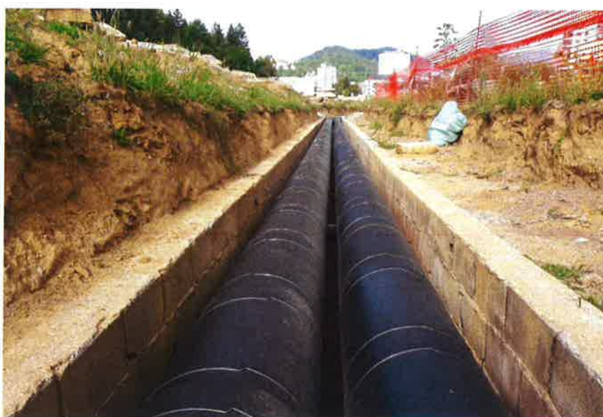
Slika 8: Obnovljena izolacija vročevoda (pogled v smeri J 5517)
