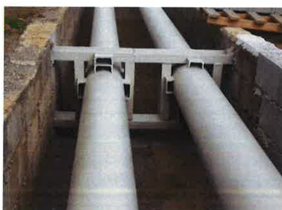
Slika 6 LEVO: Stanje fiksne podpore pred sanacijo; DESNO: Antikorozijska zaščita
