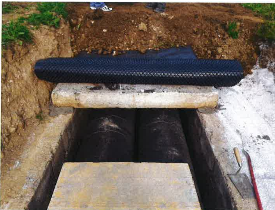
Slika 10: Pokrivanje kinete s krovnimi ploščami
