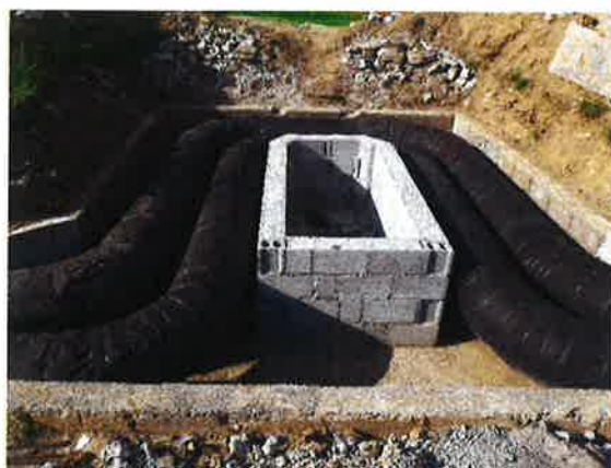
Slika 5 LEVO: Stanje lire pred sanacijo; DESNO: Gradbena obnova (razširitev) lire kinete
