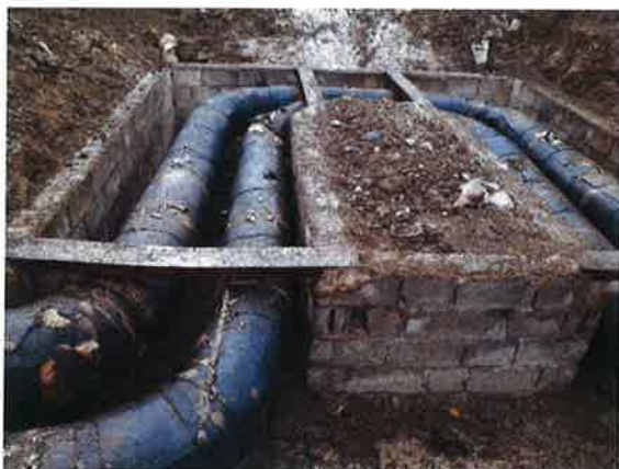
Slika 5 LEVO: Stanje lire pred sanacijo; DESNO: Gradbena obnova (razširitev) lire kinete
