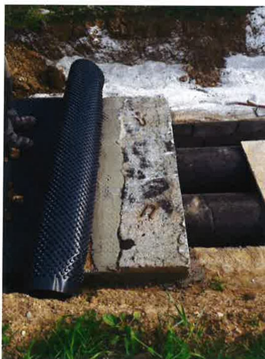
Slika 11: Tesnjenje stikov plošč in vgradnja čepaste folije
